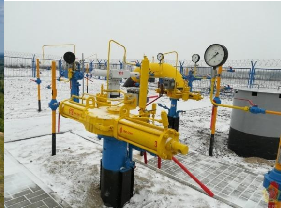
Рис. 33. Узел задвижек
