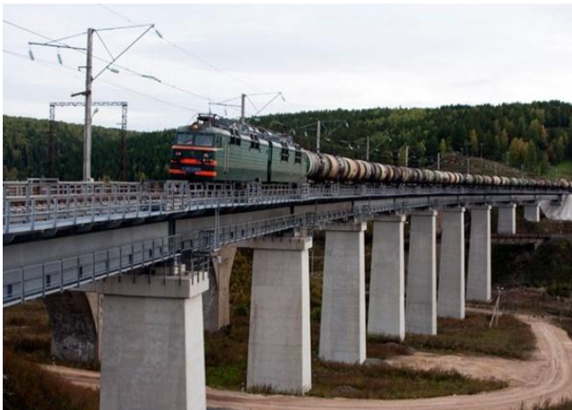
Рис. 16. Путепровод железнодорожного пути
