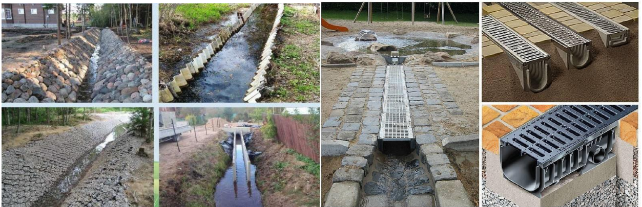
Рис.42. Открытые водоотводящие устройства
