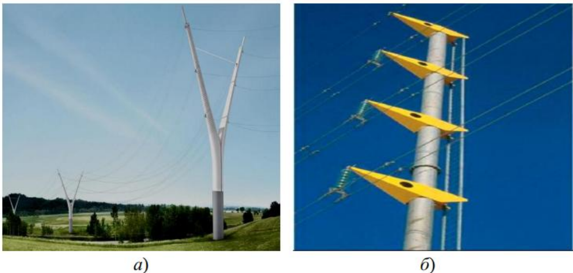
Рис.5. Опоры ВЛ из композита: а – двухцепной; б – одноцепной ВЛ
