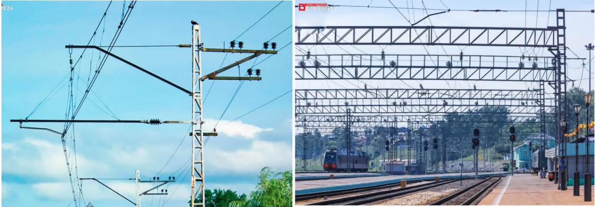
Рис. 22. Контактная сеть
