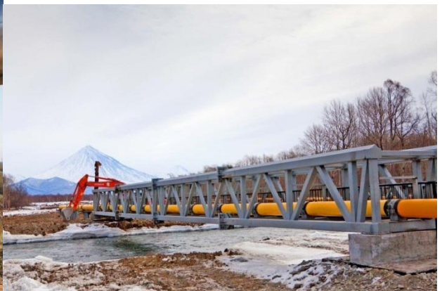
Рис.35. Трубопровод на эстакаде
