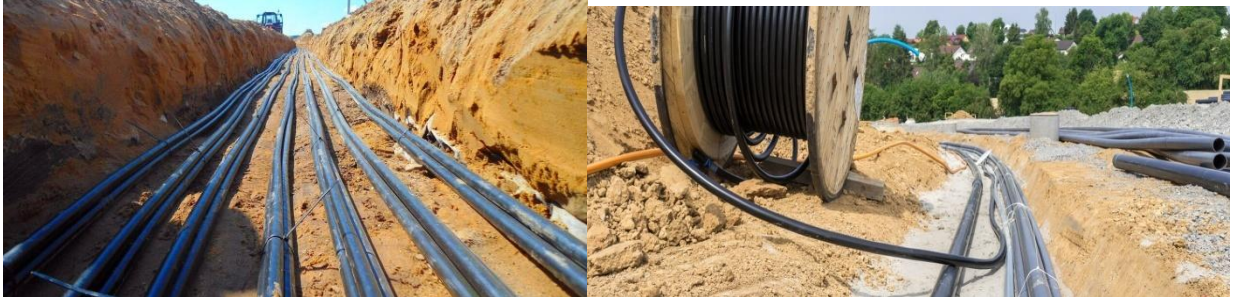
Рис.47. Траншейный способ укладки кабеля
