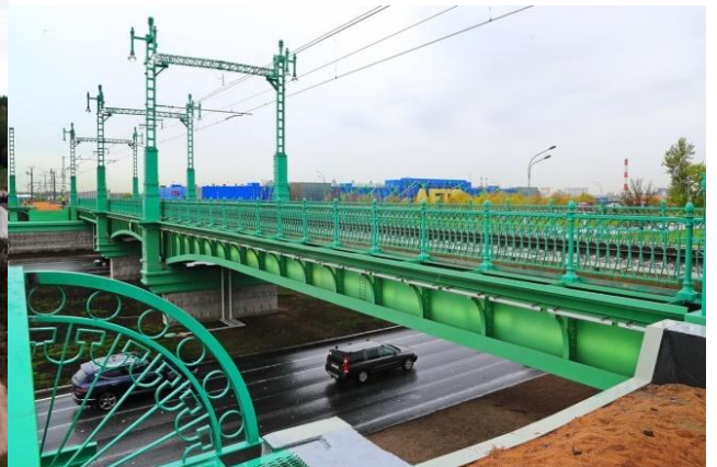
Рис. 17. Эстакада железнодорожного пути
