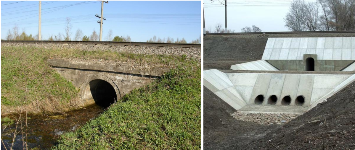
Рис. 18. Водопропускные трубы
